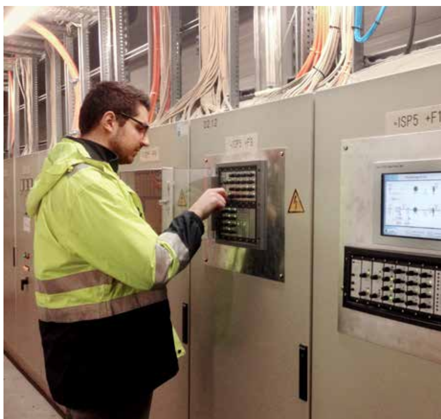
Zentrale Lüftungsanlage: Letzte Funktionsprüfung nach Installation der neuen Klima-Steuerung
